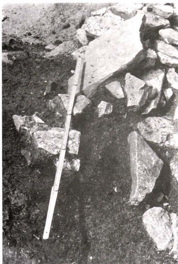
Obr. 24. Detail trámu zapuštěného v kamenech nároží.
