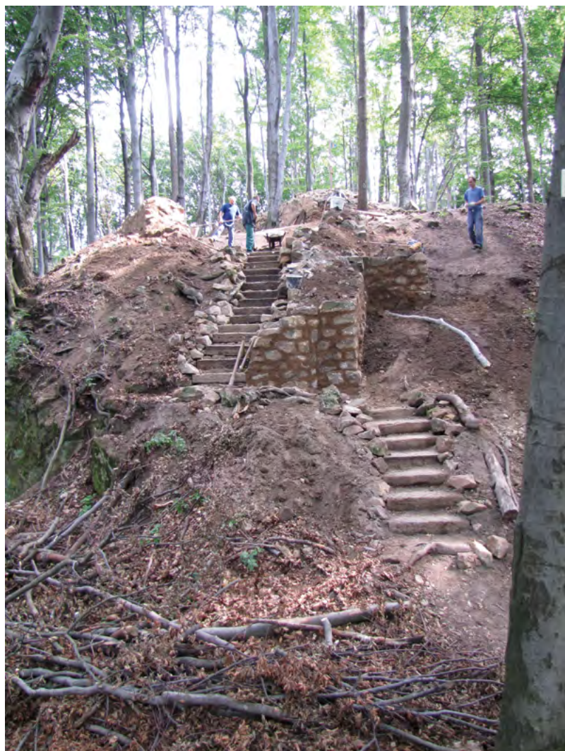
↑ Brána na jihozápadní straně jádra hradu v době oprav. Pohled od jihovýchodu. Foto R. Vrla 2013
