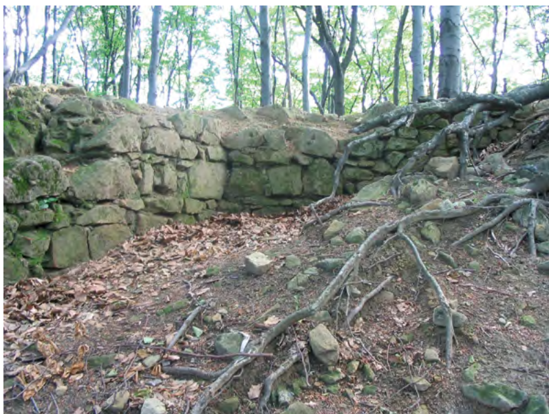
↑ Vnitřní kout obvodové hradby jádra, pohled od jihu. Foto R. Vřla 2013
