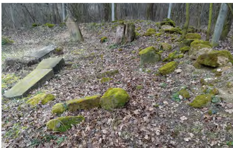
↑ Kamenná destrukce hřbitovní zdi. Foto A. Knechtová 2015
