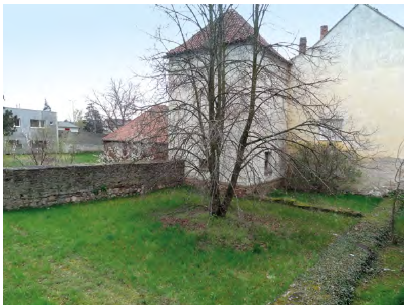
↑ Pozůstatky obvodových zdí lodi a předsíně kostela přiléhající k věži a hlavní budově. Foto A. Knechtová 2015
