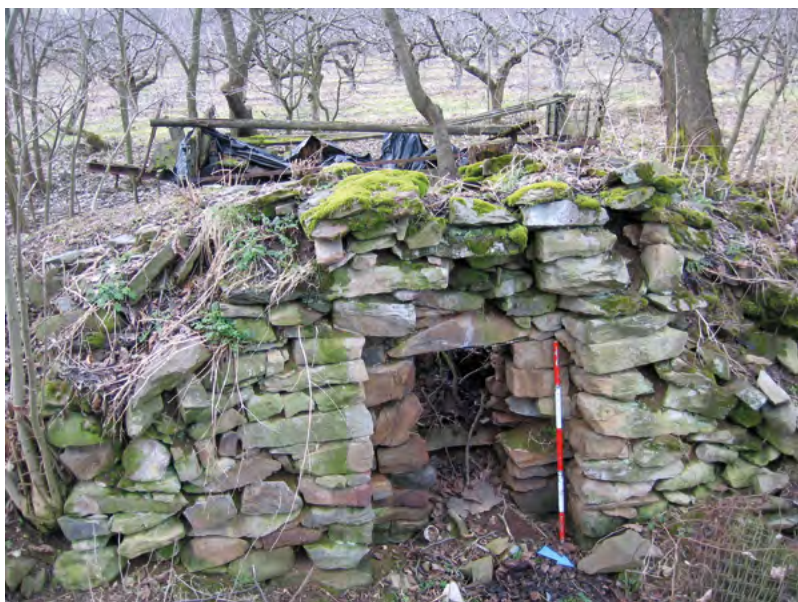
↑ Navrátilova pec v Blažově za humny statku čp. 17, pohled od severovýchodu. Foto K. Faltýnek
