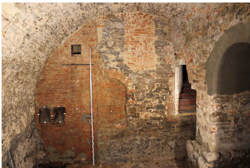
↑ Valenou klenbou zaklenutý suterén nejstaršího jádra hradu s dodatečně vloženou arkádou. Foto P. Kaniová
