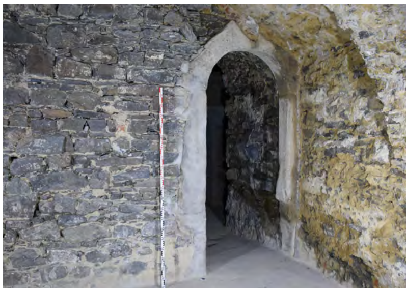
↑ Vstupní portál suterénní místnosti nejstaršího identifikovatelného stavebního jádra hradu. Foto F. Kolář
