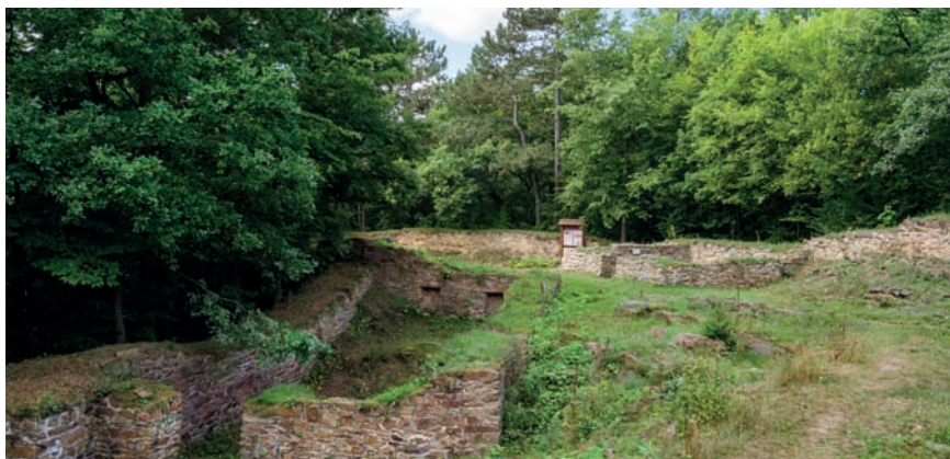
← Hradní jádro od severovýchodu. Vlevo palác Jana Roháče z Dubé, v pozadí objekt hradní kuchyně. Foto Z. Kačerová, 2014.
