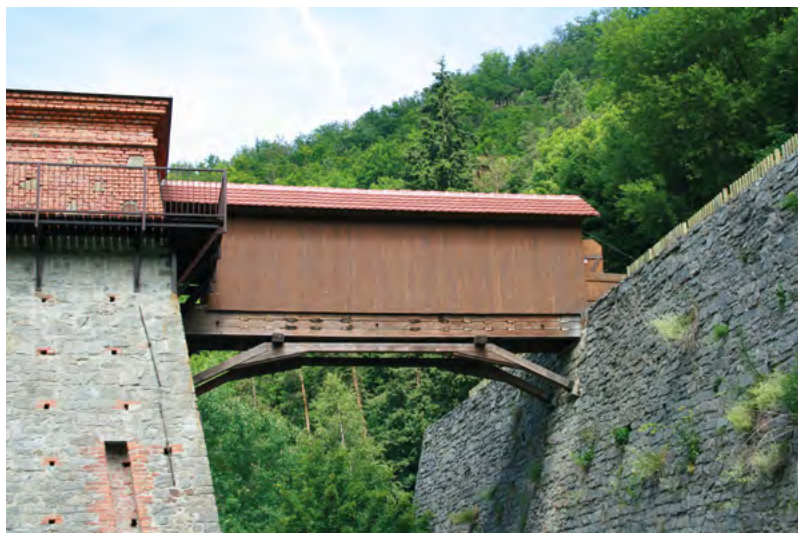
↑ Vysoká pec Františka, rampa k peci. Foto K. Sklenář 2009
