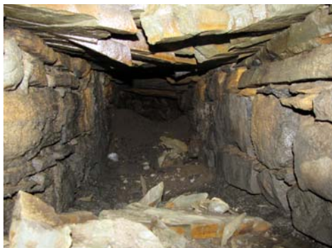
16 Pohled do jedné z větví kanalizační stoky zachycené v ulici Mostní (foto Z. Schenk)
