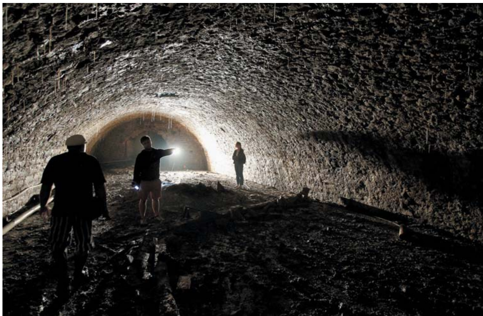
79 Přerov. Na Marku. Pohled od západu. Interiér pivovarského sklepa vestavěného do původního městského příkopu (foto J. Vojzola)
