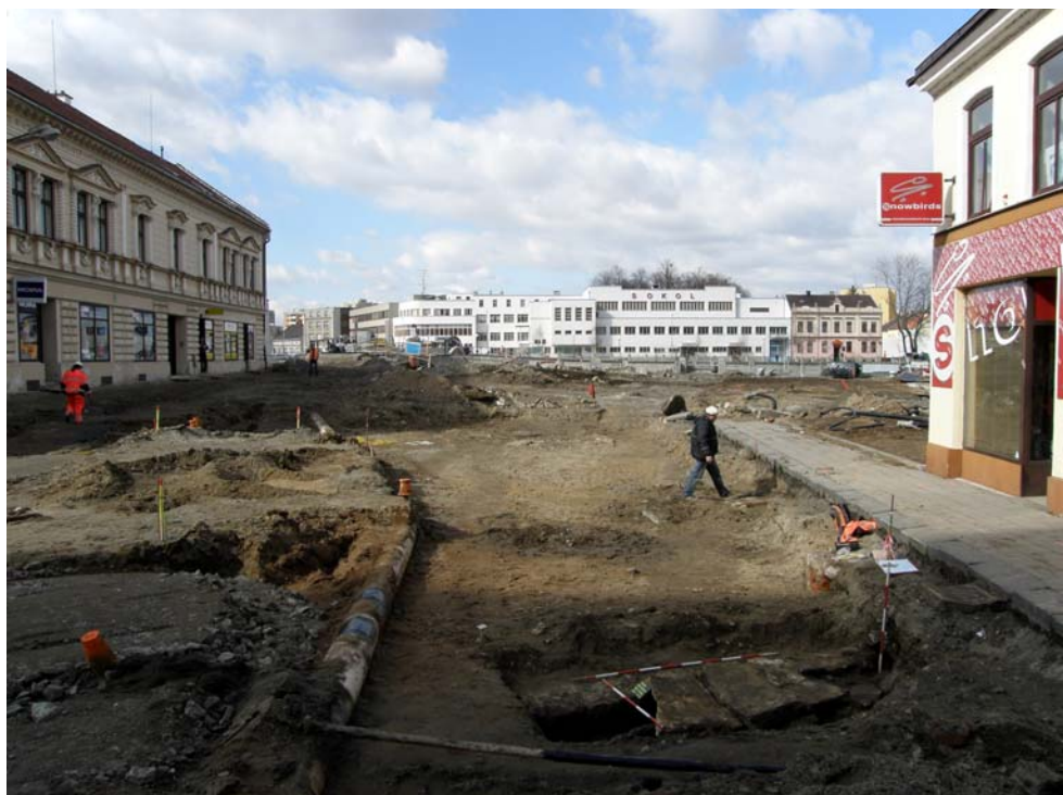
14 Celkový pohled na odkrytý úsek kanalizační stoky v místě křížení ulic Mostní a Jateční
