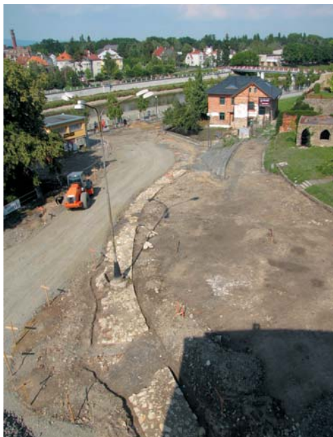
74 Přerov. Na Marku. Část odkrytého průběhu torza barbakánu (foto Z. Schenk)
