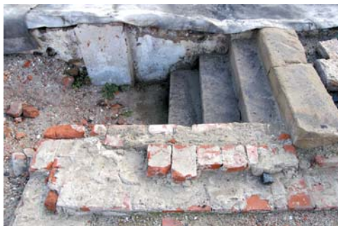
45 Přerov. Na Marku. Detail částečně odkrytého schodiště vedoucího do suterénu pod sokolovnou, ve 30. letech 20. století adaptovanou na „Bio Alfa“ (foto Z. Schenk)
