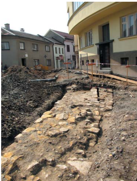
75 Přerov. Na Marku. Část odkrytého průběhu barbakánu v místě zesílení konstrukce (foto Z. Schenk)
