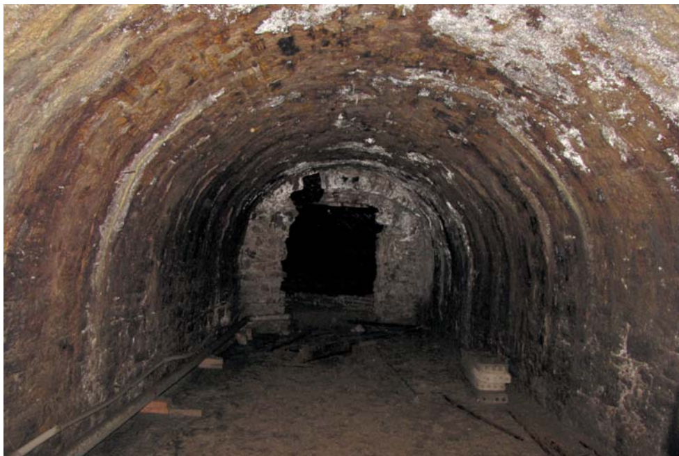
80 Přerov. Na Marku. Pohled od východu. Interiér pivovarského sklepa vestavěného do původního městského příkopu (foto J. Mikulík)
