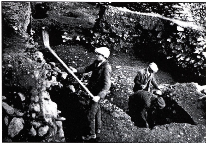
Nahoře: pohled na výzkum K. Snětiny z roku 1925. V pozadí příkop, v popředí kamenná destrukce hradby.
