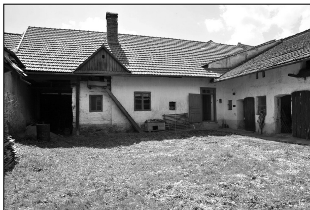
Obr. 6: Sebrany (okr. Blansko). Pohled ze dvora (od severovýchodu) na obytnou část domu (foto J. Pokorný 2011).
