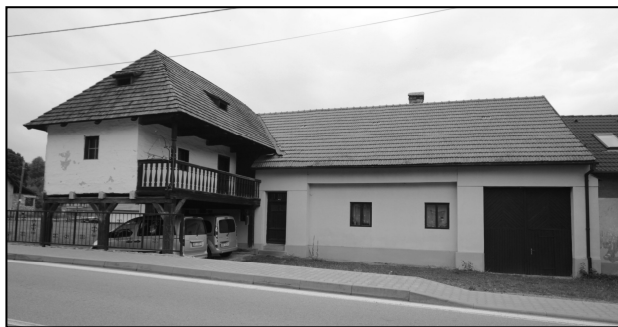
Obr. 2: Sebranice (okr. Blansko). Současný stav domu čp. 36, pohled z návsi od jihu (foto Archäia Brno o. p. s. 2013).
