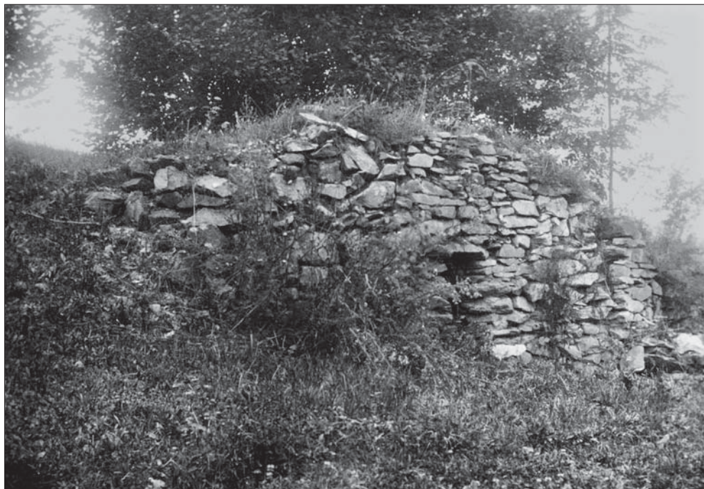
Obr. 8. Blažov, dnes již zaniklá tzv. Sloukova pec náležející k č. p. 9, stojící při polní cestě jižně od stávající zástavby obce, první polovina 20. století. Foto: archiv autorů.
